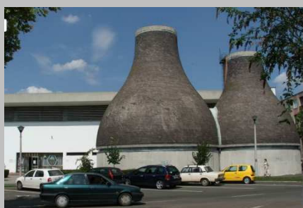
Termálfürdő, sajátos stílusú helyi épület
